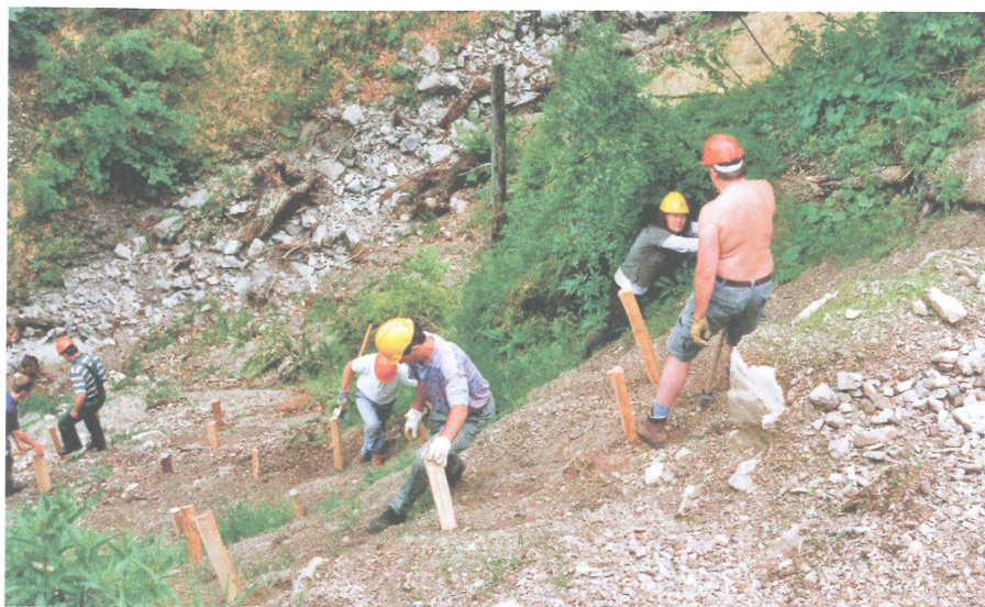
Zur Sicherung des Hanges wurden Lärchenpflocke eingeschlagen.
