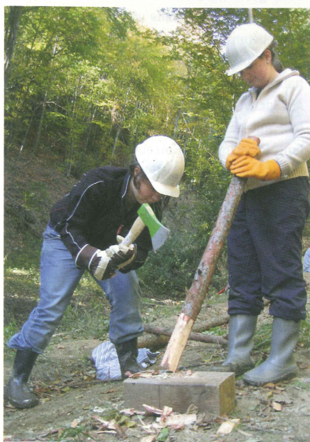
Vorbereitungsarbeiten für die Querentwässerung
